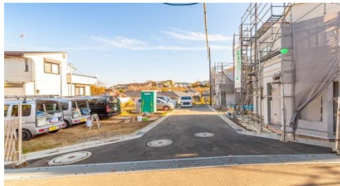
<建設予定地写真>
