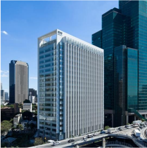
【アークヒルズサウスタワー外観】
