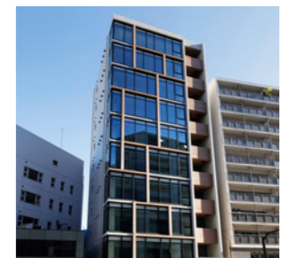
辦公大樓一例(澀谷區千駄谷)
